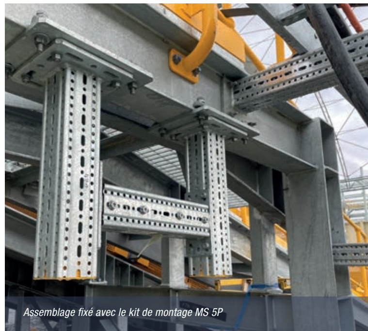
Supports préassemblés prêts à l'emploi à Canning Vale
